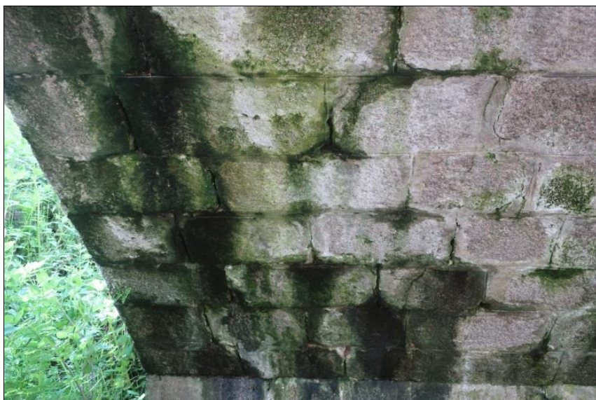
intenzivní průsaky a biologické napadení na spodním líci zdiva klenbového pasu nad O1
