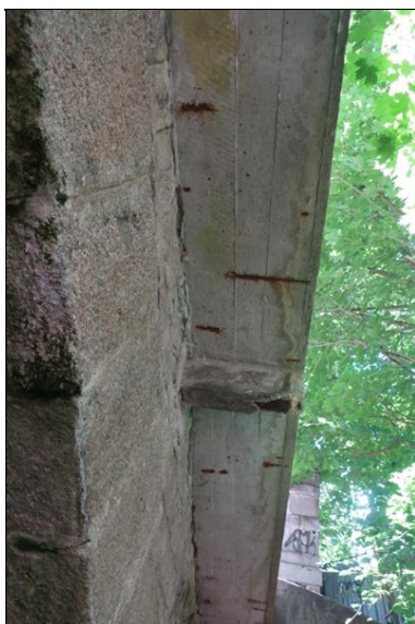
stopy po průsacích a koroze výztuže na spodním líci železobetonové konzoly podporující IS na levé straně mostu
