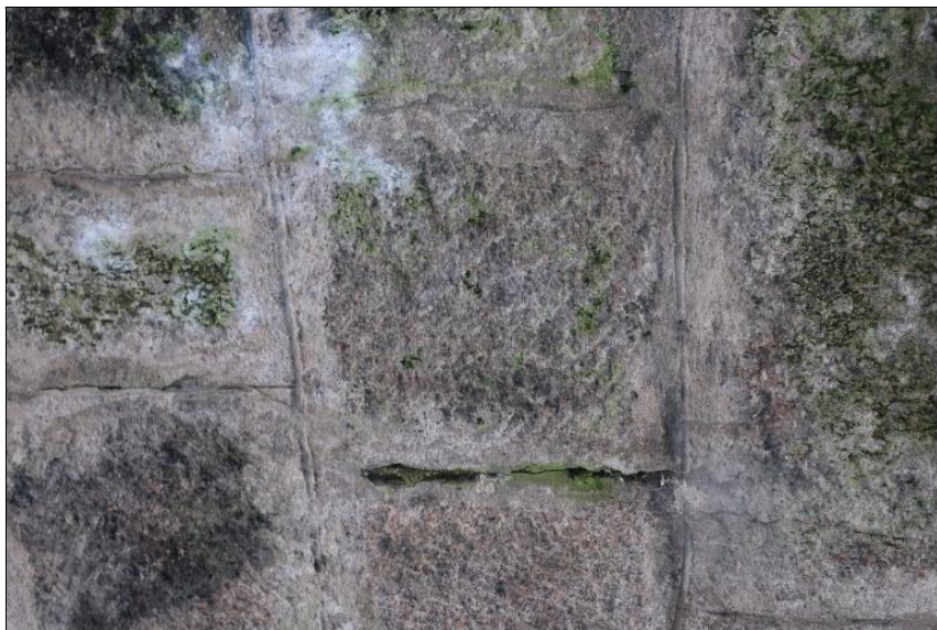
výluhy pojiva na spodním líci klenbového pasu
