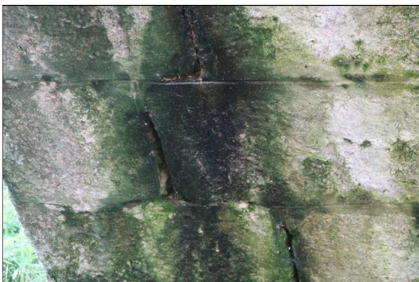
DTTO detail s volnými sparami
